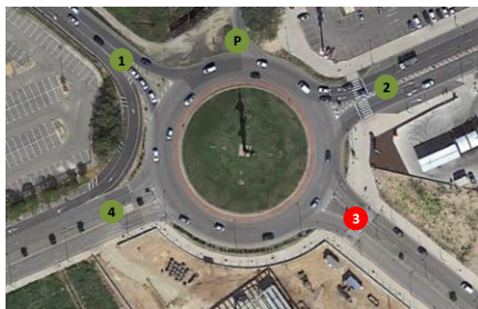
Glorieta que intercepta la CV-43 con la zona de Tulell
